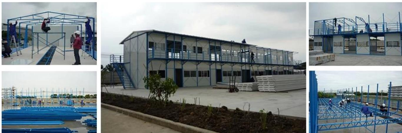
**СБОРНОЕ ЗДАНИЕ** (тип К) - это стандартный модульный дом, который может быть спроектирован как одноэтажный или многоэтажный. Внутренняя планировка может быть спроектирована в соответствии с требованиями заказчика.
