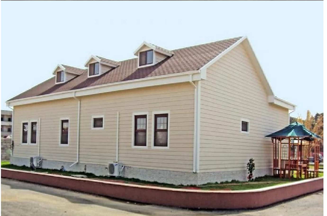
Casa de paneles sándwich
