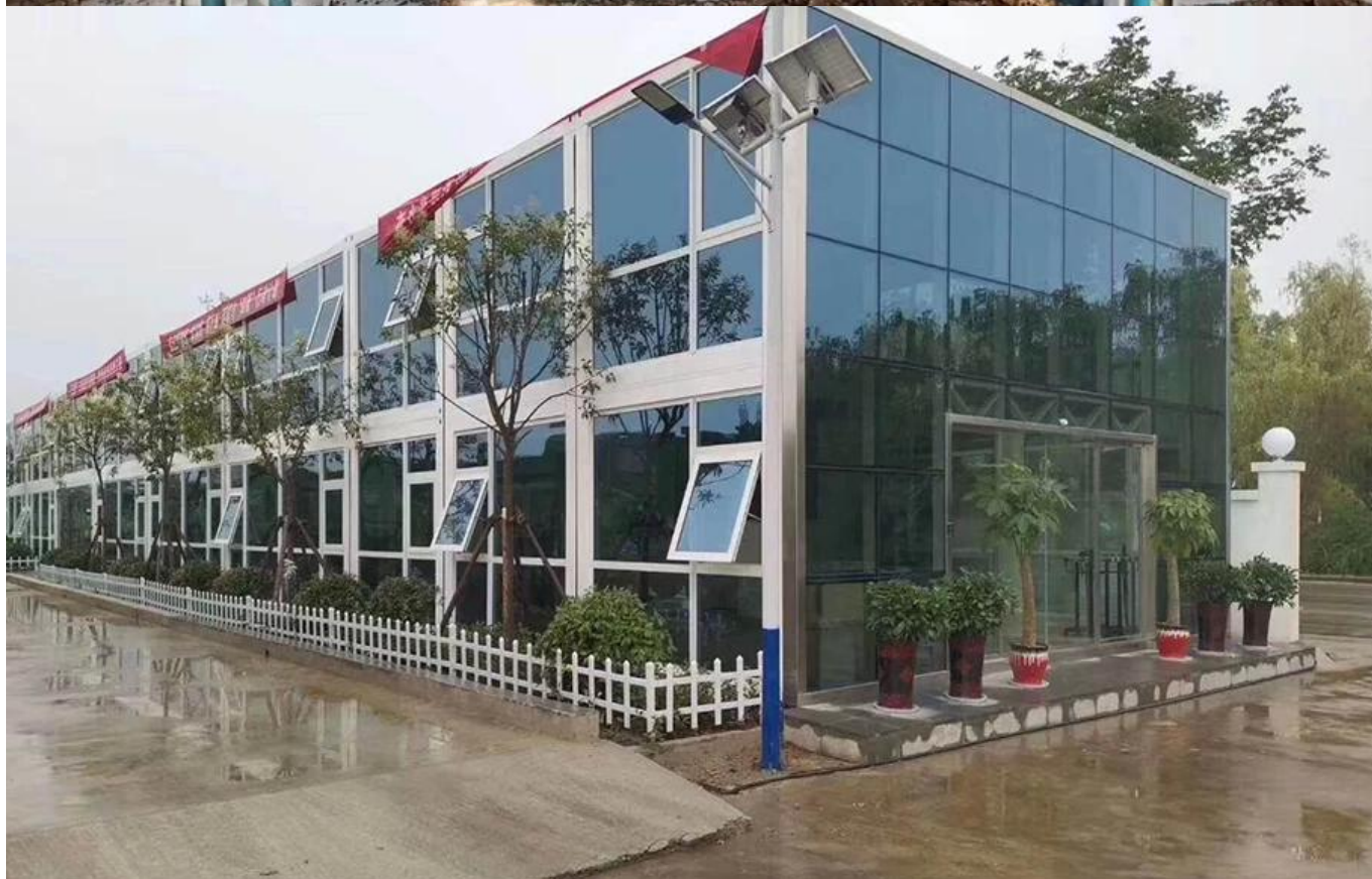
Materiales Introducción de prefabricado casa contenedor
